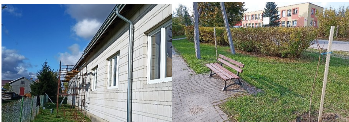
Rysunek 53 Budynek świetlicy wiejskiej w Duczyminie oraz posadzone drzewka na placu wiejskim w Duczyminie, Źródło: Urząd Miasta i Gminy w Chorzelach.
