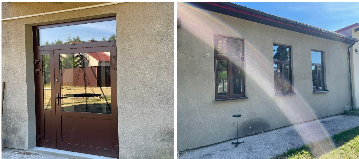
Rysunek 61 Budynek świetlicy w Budkach z wymienionymi drzwiami oraz okami, źródło: Urząd Miasta i Gminy w Chorzelach
