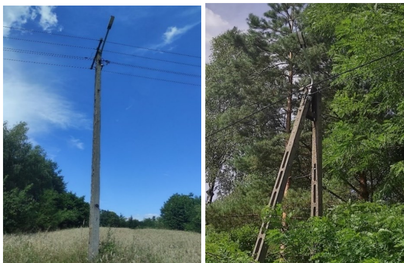
Rysunek 41 Dowieszona oprawa oświetlenia ulicznego LED o mocy 50W w miejscowości Stara Wieś, Źródło: Urząd Miasta i Gminy w Chorzelach.
