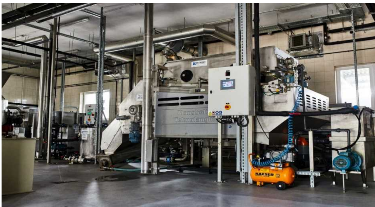
Rysunek 21 Przebudowa i rozbudowa miejskiej oczyszczalni ścieków w Chorzelach, ob. nr 8 budynek technologiczny, ob. nr 9 WKF, ob. nr 10 zbiornik osadu, ob. 4 przepompownia ścieków surowych, źródło: Urząd Miasta i Gminy w Chorzelach.
