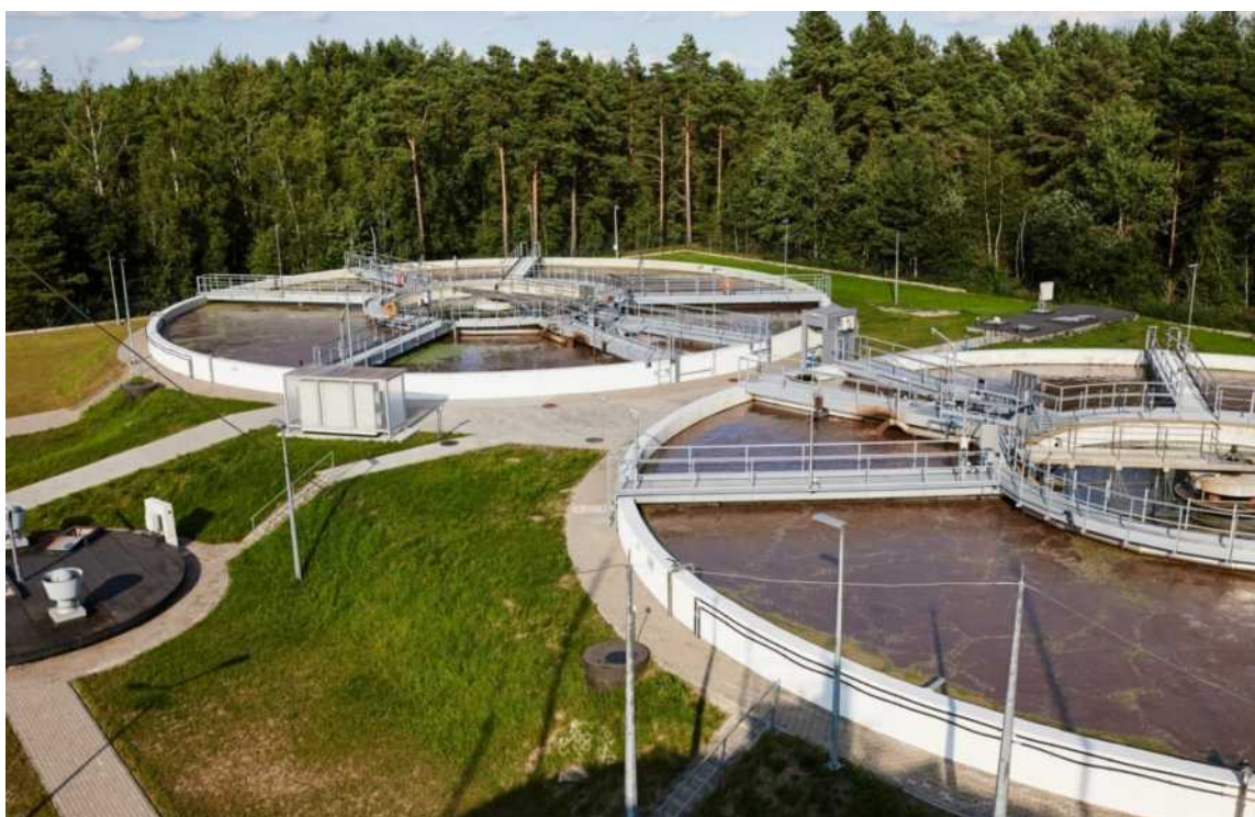
Rysunek 19 Przebudowa i rozbudowa miejskiej oczyszczalni ścieków w Chorzelach, ob. nr 5A i ob. nr 5B wielofunkcyjne reaktory biologiczne, źródło: Urząd Miasta i Gminy w Chorzelach
