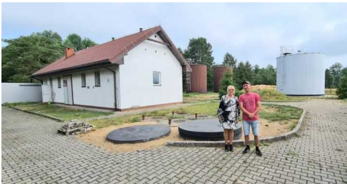
Rysunek 18 Stacja Uzdatniania Wody w miejscowości Zaręby, źródło: Urząd Miasta i Gminy w Chorzelach
